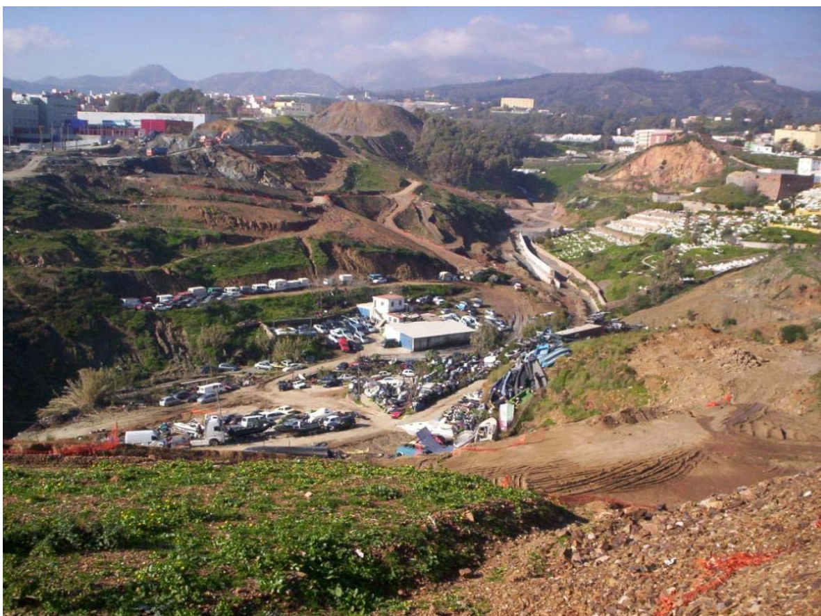
Imagen nº 32: Aspecto general de la parcela B4. Obsérvese: (1) la ladera tapizada por niveles coluvionares parcialmente desmantelados; (2) depósitos de fondo de valle asociados a la dinámica del arroyo de Las Colmenas; (3) al fondo nivel antrópico
