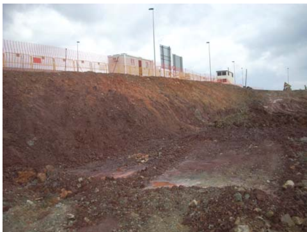
Imagen nº 30: Aspecto general de las argilitas del Permotrías.
