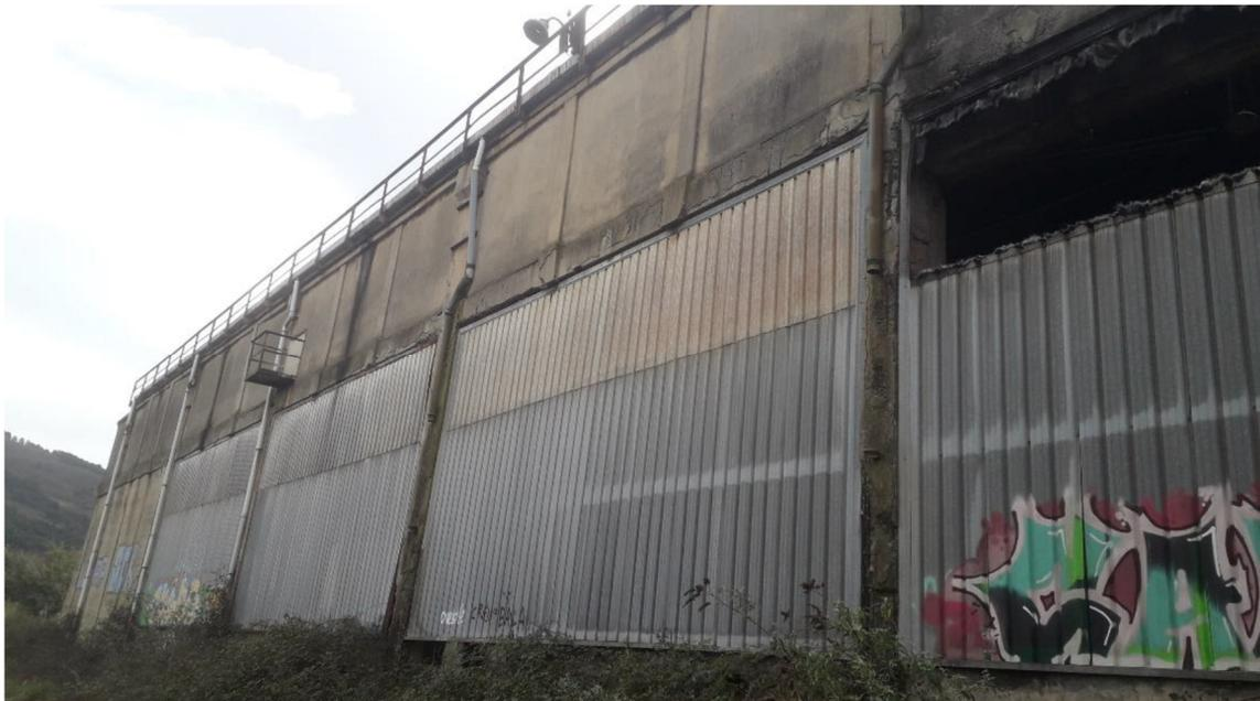
**Figura 24:** Detalle cerramiento perimetral en extremo Este de Nave 1.
