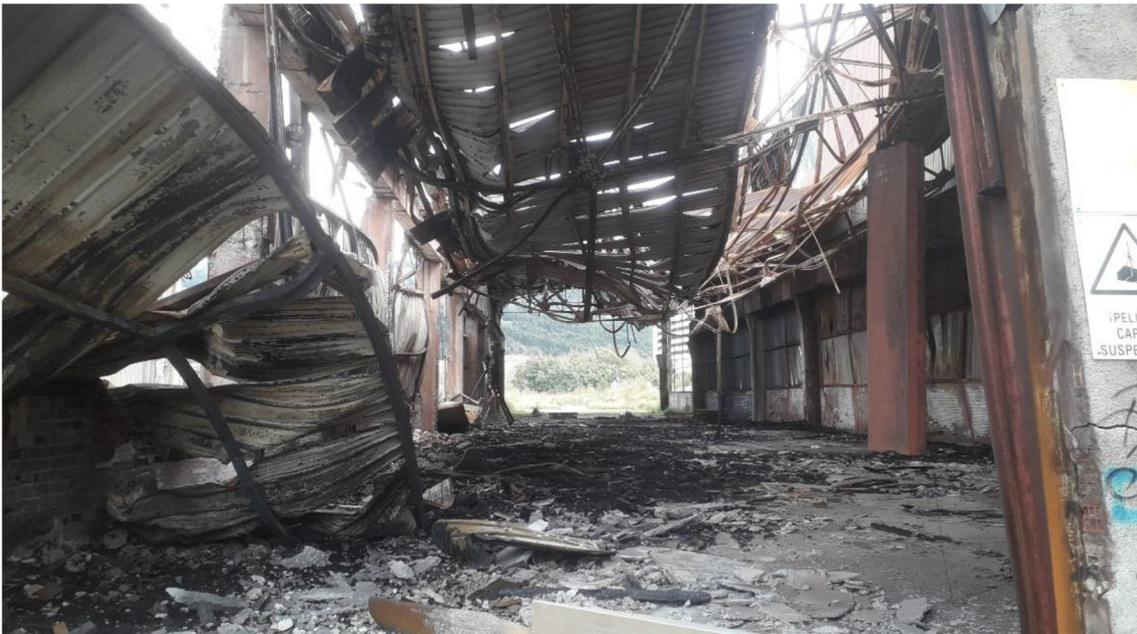
**Figura 22:** Detalle interior Nave 1, margen Oeste con muro lateral y cubierta colapsados.
