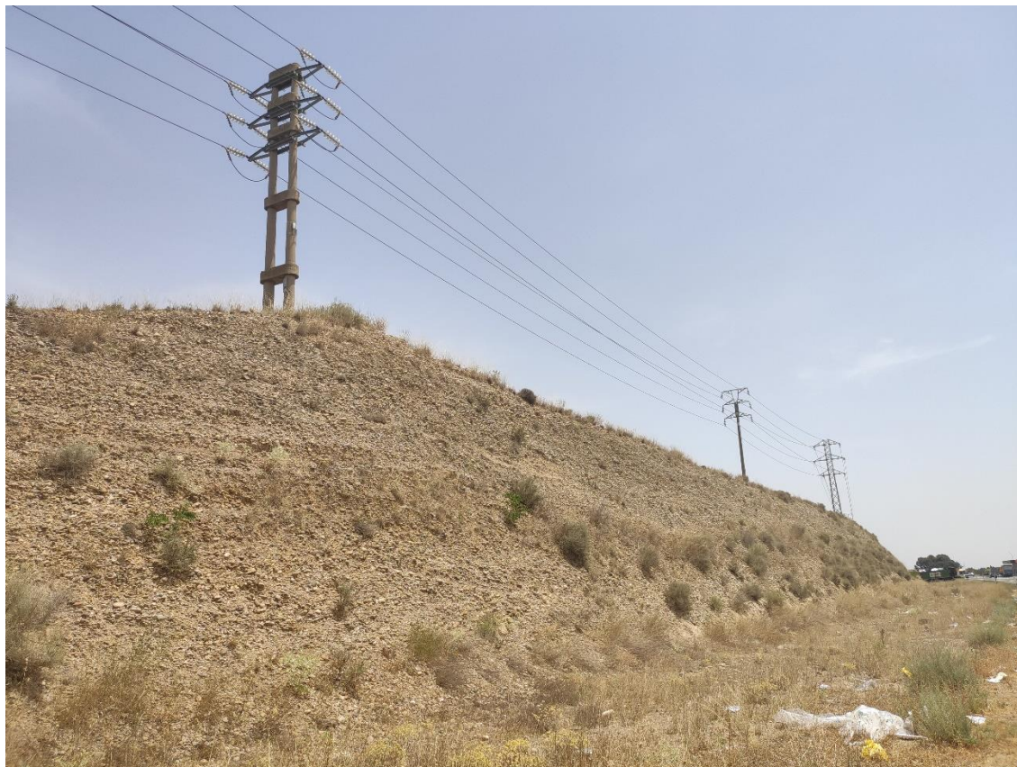
Vista del talud de la meseta desde la N-II, se observa claramente el estrato de arenas y gravas.
