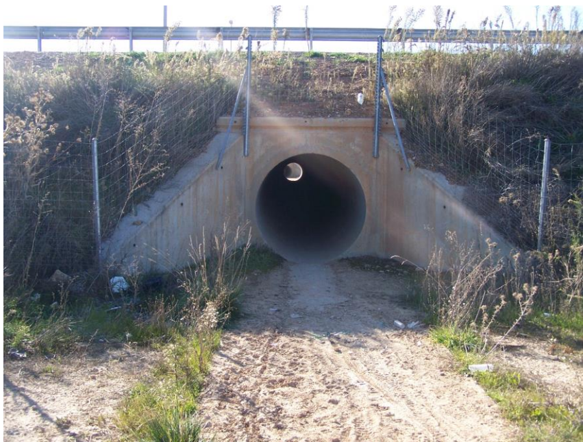
Foto nº 19: Vista de la obra de paso de H. A. de diámetro 1800 mm al Sur del Sector bajo la A-43.
