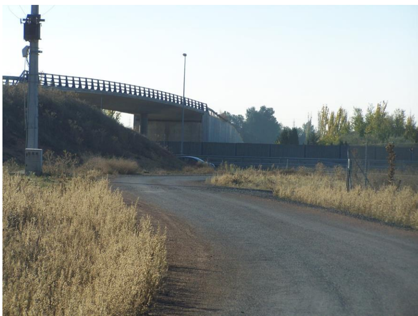
Foto nº 16: Vista del camino a la derecha del puente.
