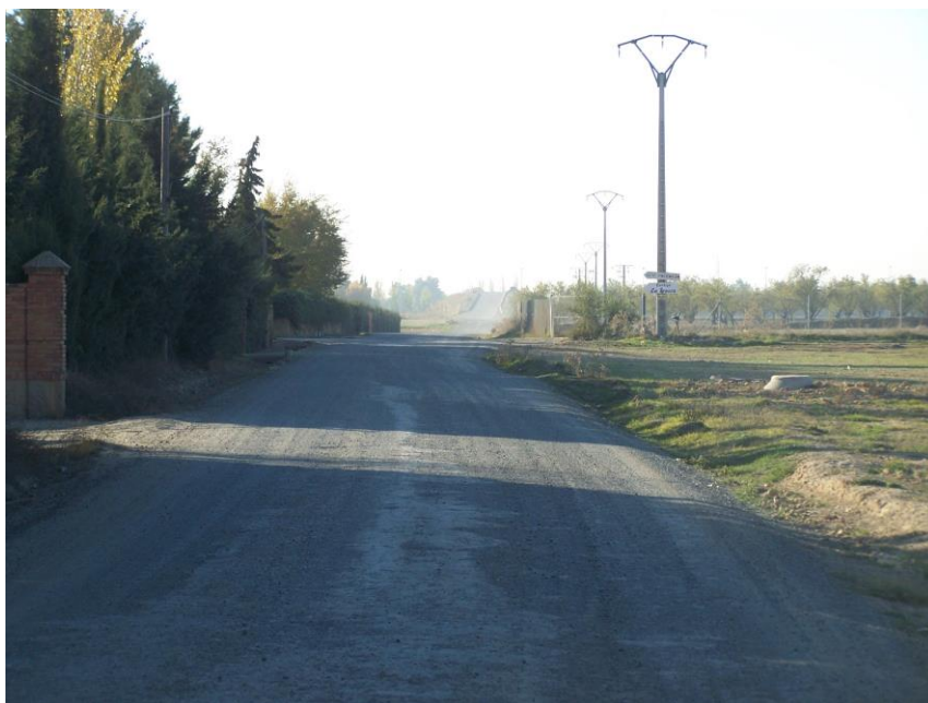
Foto nº 6: Vista del Camino de la Torre de norte a sur, límite con Miguel Turra.
