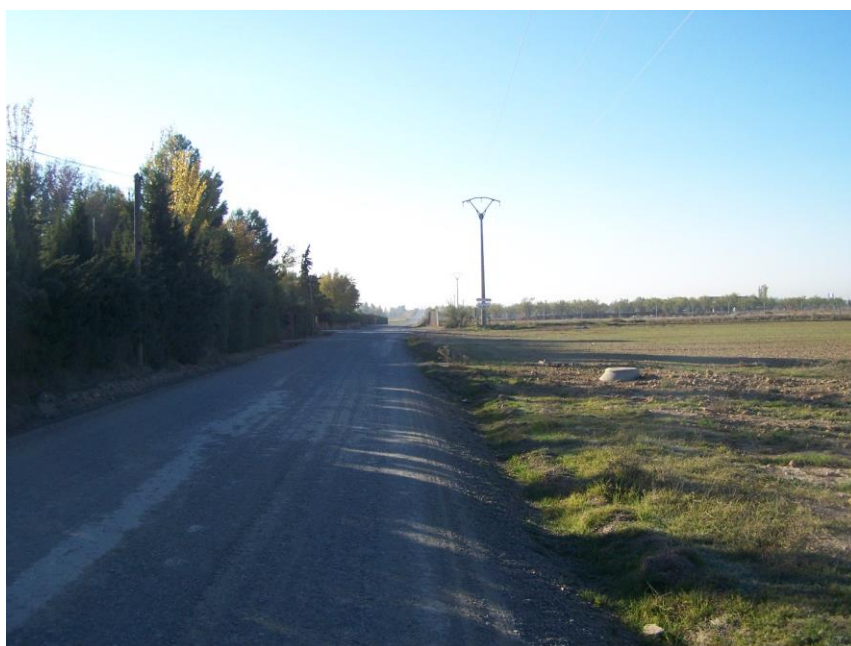
Foto nº 8: Vista del Camino de la Torre de norte a sur, línea de media tensión aérea, pozos abastecimiento.
