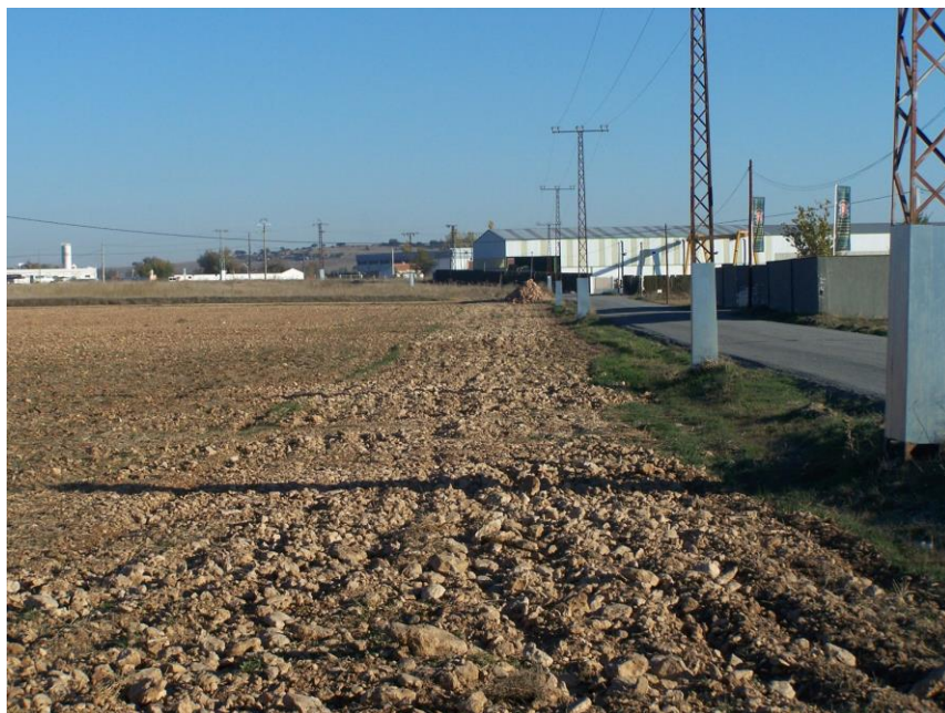
Foto nº 3: Vista de la red de Media tensión aérea paralela al Camino de la Torre de Sur a Norte.
