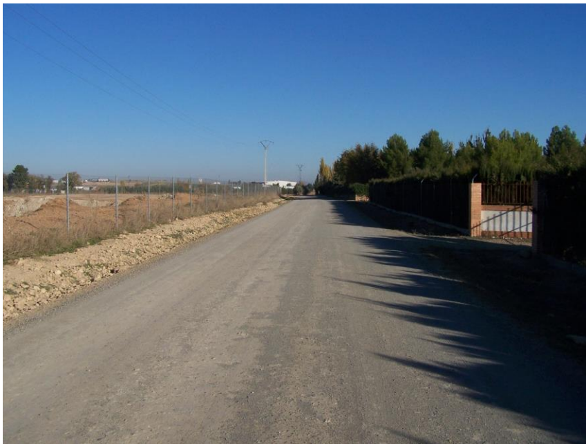
Foto nº 12: Vista de la zona de excavación contigua a la edificación existente fuera del sector.
