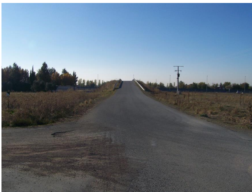
Foto nº 14: Vista del final del Camino de la Torre justo antes del puente.
