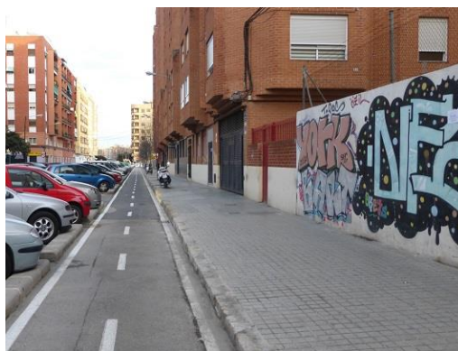
Fotog. 24. Acera sur y accesos a edificio de viviendas.
