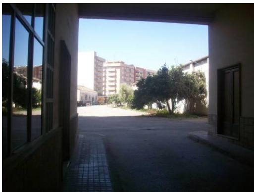
Fotog. 3. Acceso al Servicio Militar de Construcciones desde la calle San Vicente Mártir.
