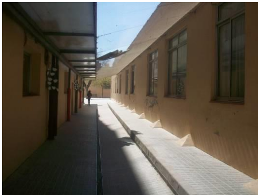
Fotog. 36. Edificio de aula principal (dcha.) y bajos de edificios recayentes a calle San Vicente Mártir (dcha.).
