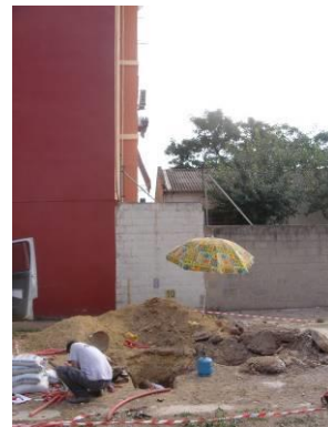
Fotog. 63. Toma de muestras en calicata durante la campaña geotécnica.
