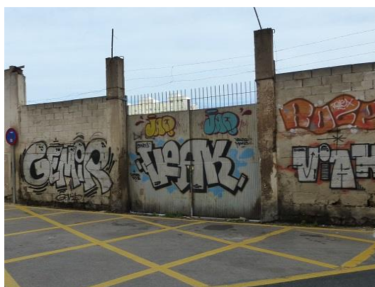
Fotog. 17. Puerta acceso a los terrenos de la actuación en esquina suroccidental
