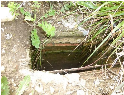
Fotog. 62. Arqueta existente.
