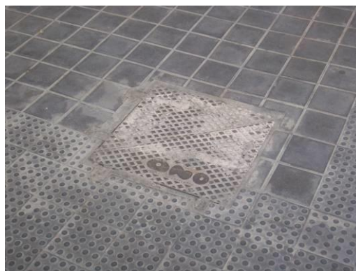
Fotog. 12. Tramo de la acera sur reurbanizado.
