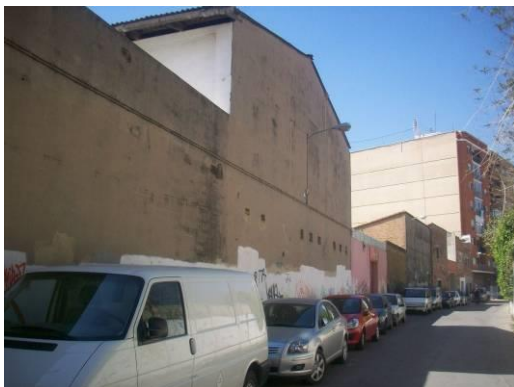
Fotog. 9. Naves en el tramo más próximo a la calle San Vicente Mártir.
