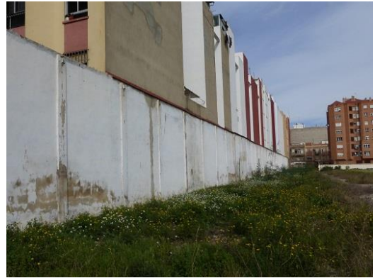
Fotog. 61. Vista lateral de la explanada principal del cuartel desde el extremo sur. En primer término, traseras de edificios.
