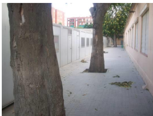
Fotog. 44. Aulas prefabricadas y arbolado interior en alineaciones.
