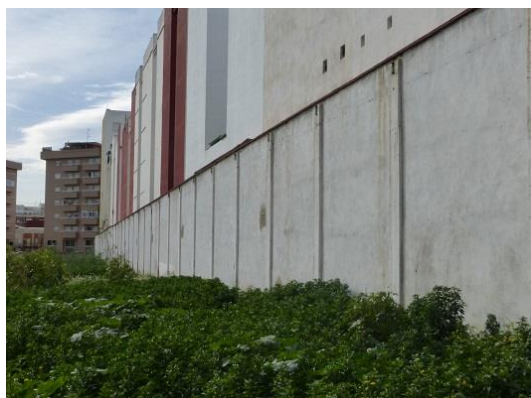
Fotog. 50. Muro y fachadas posteriores de edificaciones recayentes a calle Francisco Climent.
