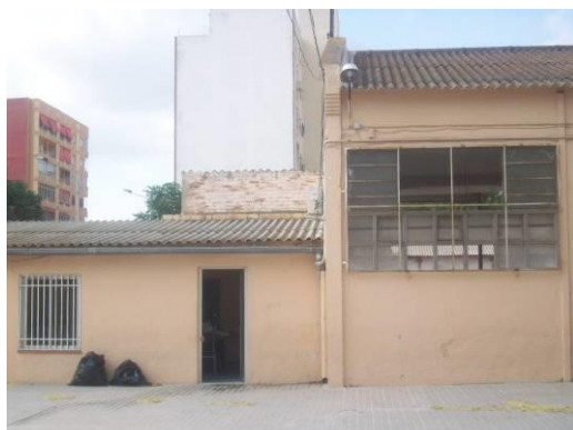
Fotog. 34. Conserjería (izqda.) y edificio adosado perteneciente al Servicio Militar de Construcciones.
