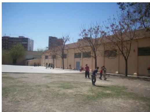
Fotog. 42. Patio y nave gimnasio.
